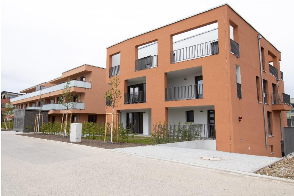
Holzhybridhaus Sindelfingen: Gebäudeensemble im Fanny-Hensel-Weg 19-23 Quelle: GWG-Gruppe
